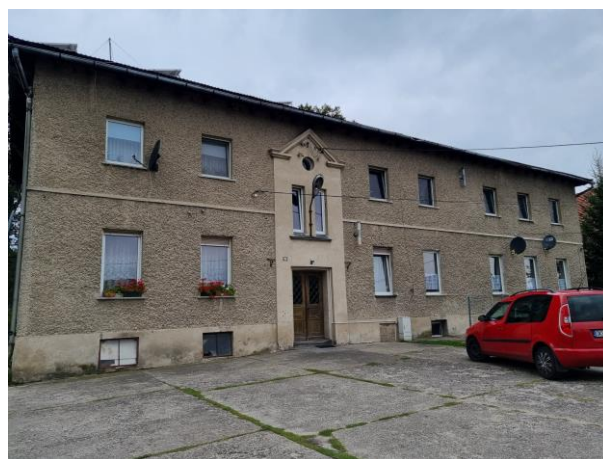
Fotografia 16. Widok na dwór w Jasieniu.
