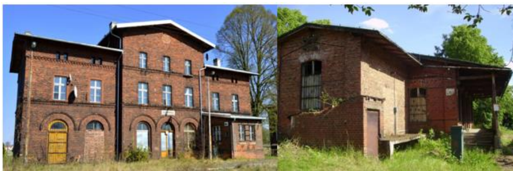
Fotografia 19. Widok na budynek stacji kolejowej w Chudobie oraz w Lasowicach Małych.
