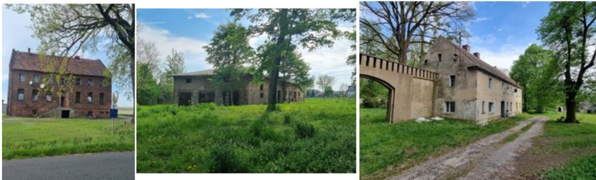
Fotografia 15. Widok na gorzelnię, wozownię oraz dom zarządcy w założeniu pałacowo – parkowym.
