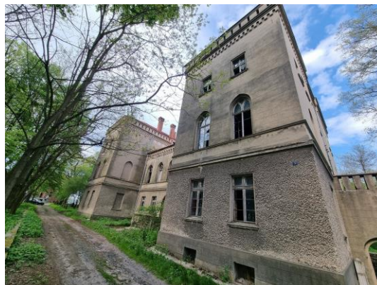
Fotografia 14. Widok na pałac w Wędryni.
