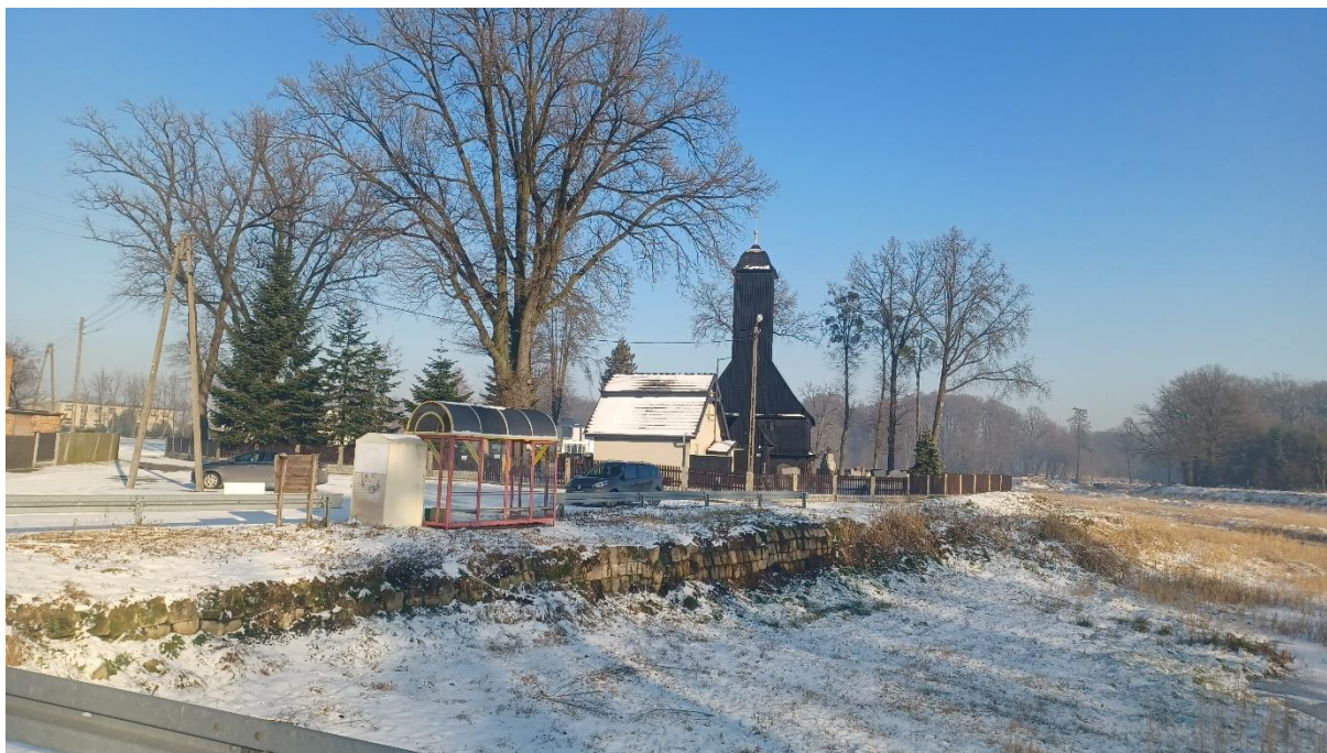
Fot. 1. Widok na kościół i parking – widok od południowego-zachodu (styczeń 2024 r.)
