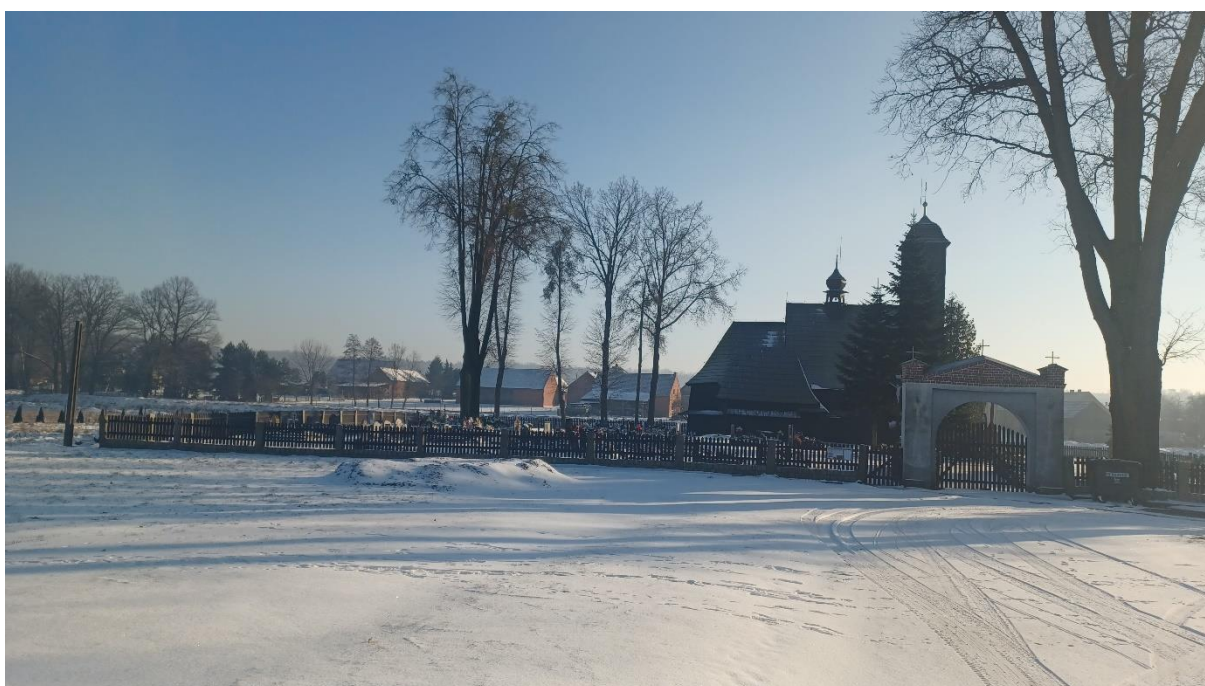
Fot. 2. Widok na kościół – widok od północy (styczeń 2024 r.)
