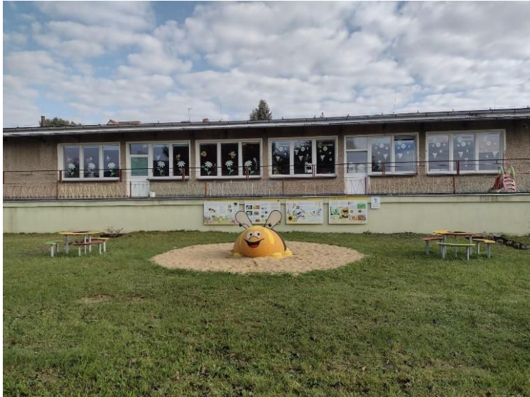
Pracownia pod chmurką urządzona w Zespole Szkolno-Przedszkolnym w Lasowicach Wielkich Przedszkolu Samorządowym w Laskowicach
