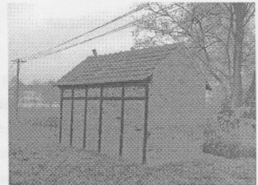
Zdj. nr 9 budynek gospodarczy przy dawnej szkole ewangelickiej
